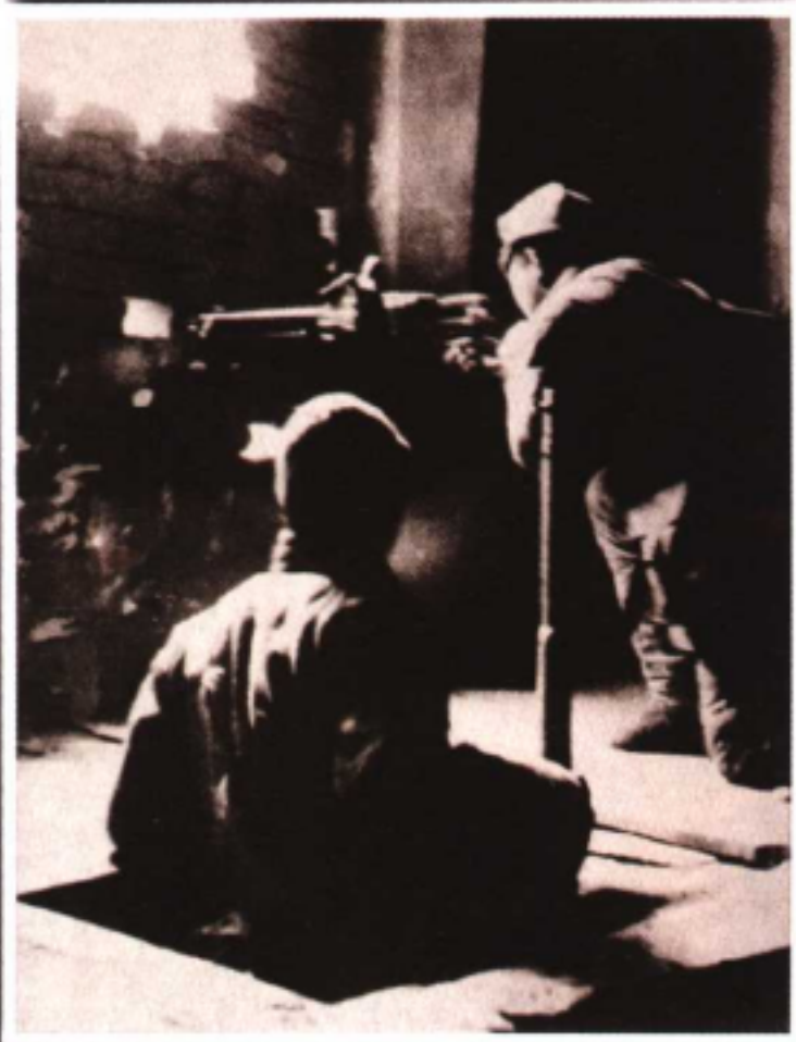
民兵从四通八达的地道网到地面工事上狙击敌人。
