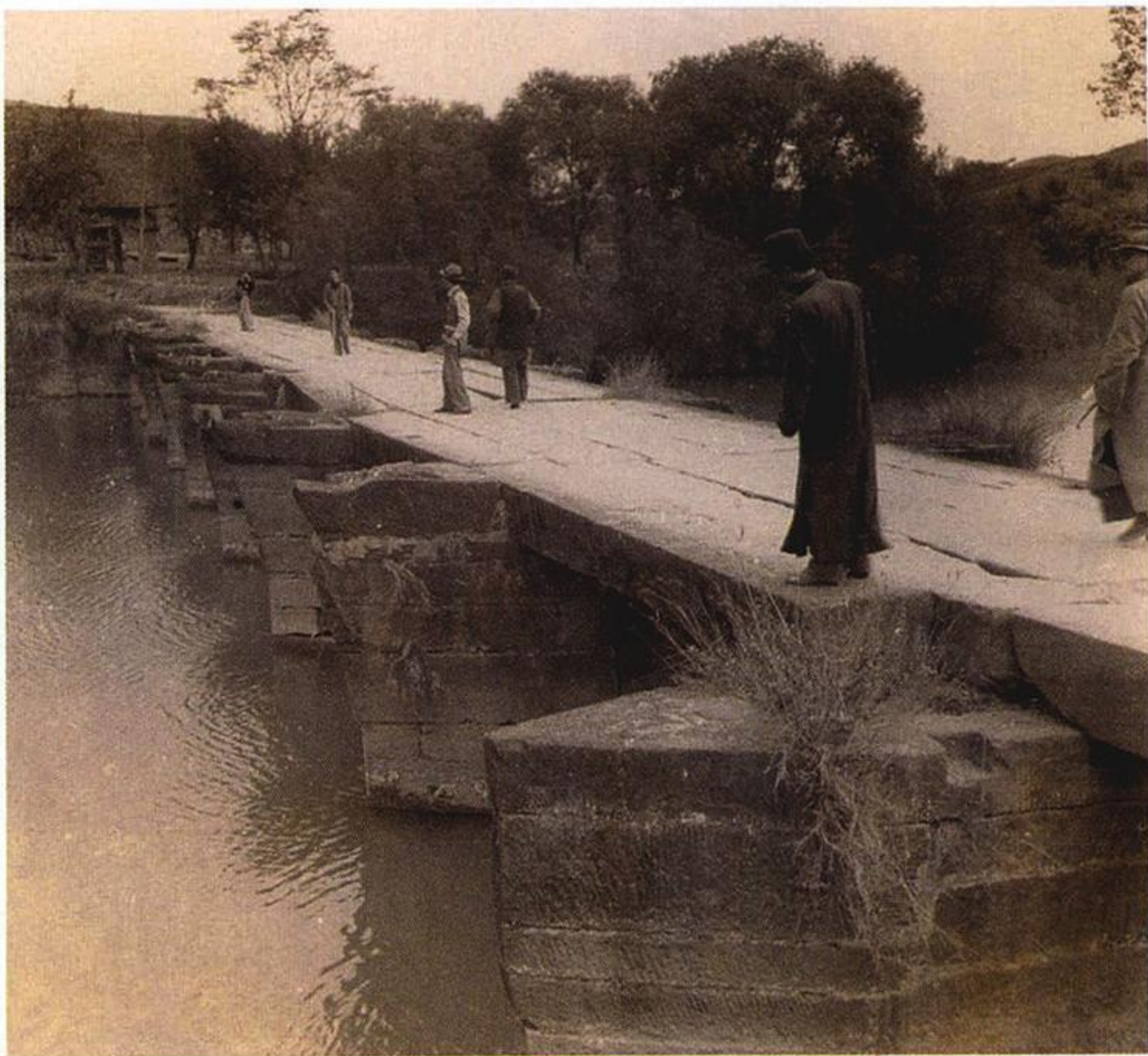
仙人桥 建造时间：不详 地点：绵阳
