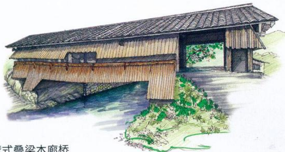
伸臂式叠梁木廊桥
