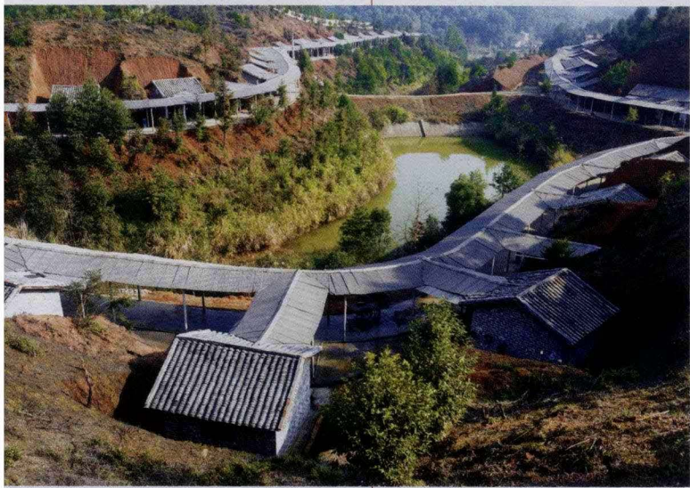
▲ 这是浏阳东信花炮厂的厂房，这种长廊式的厂房在萍浏醴地区遍地皆是。为了花炮制作的安全性，厂址选择需具备几个条件：丘陵地形，厂房三面临土，以土为防爆隔离墙。另外，要与水为邻。
