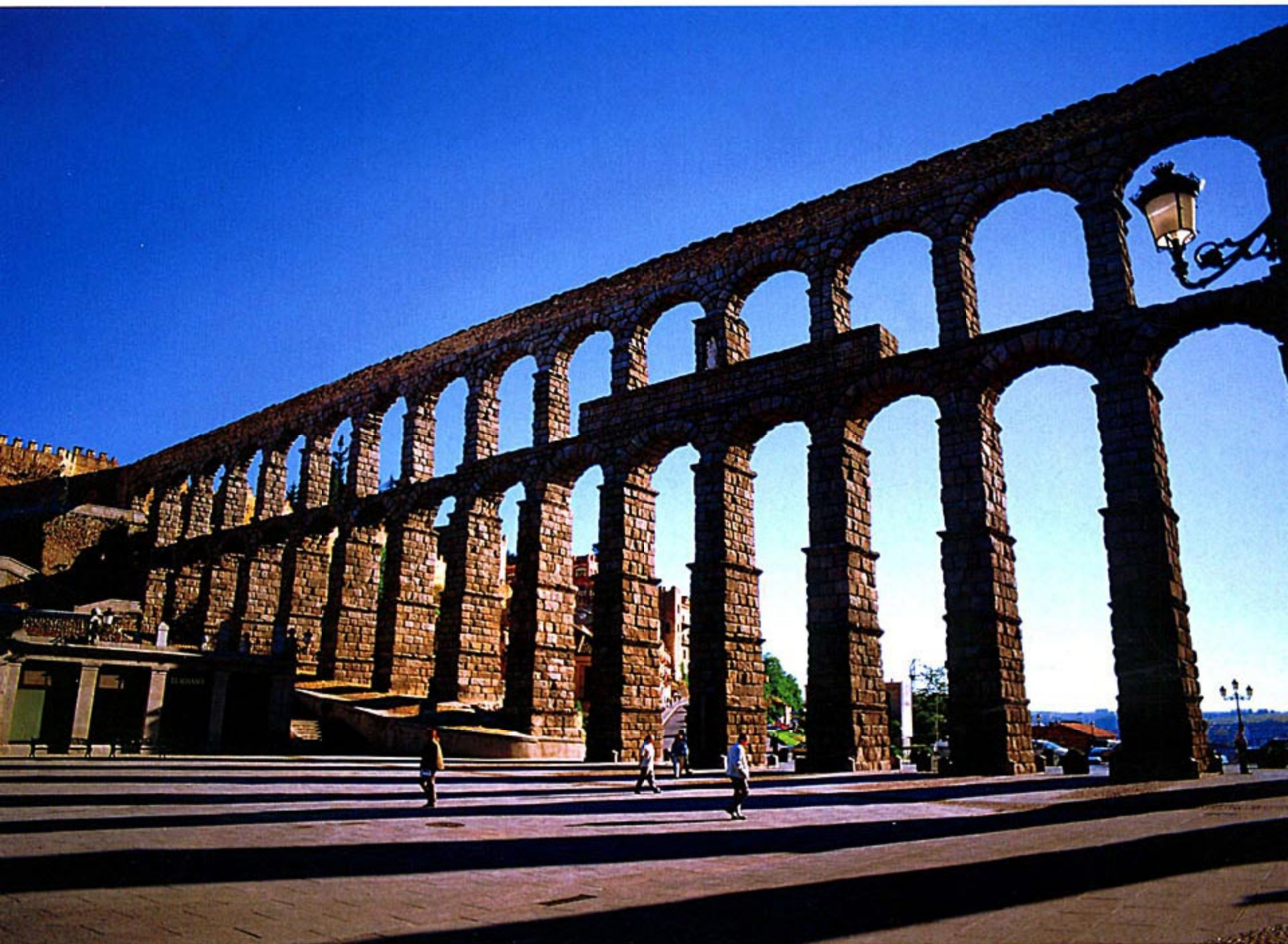
塞戈维亚是西班牙的历史名城，塞戈维亚城的罗马渡槽是罗马时代最雄伟的建筑之一，大约建于公元前1世纪前。该渡槽采用花岗岩修建，全长728米，最高处28.9米，共167孔，分为两层。至今仍在使用。摄影 / Jose Fuste Raga/c
