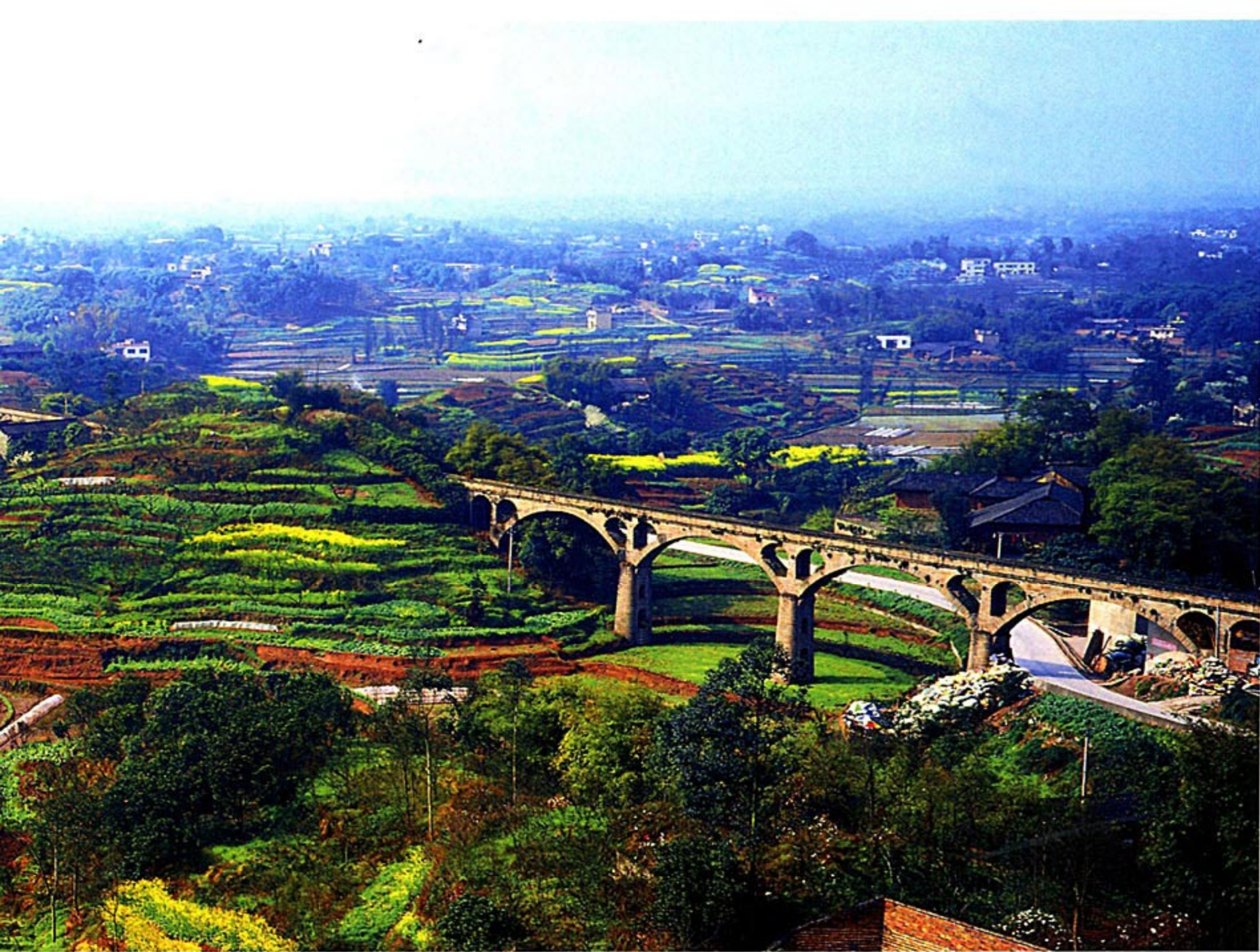
四川省泸县华丰渡槽，全长1122米，有47个大拱跨，76个小拱跨，桥墩上还有小拱。1978年竣工，使用至今。华丰渡槽是三溪口灌区的重要干渠，灌溉面积近3万亩。摄影/袁蓉荪
