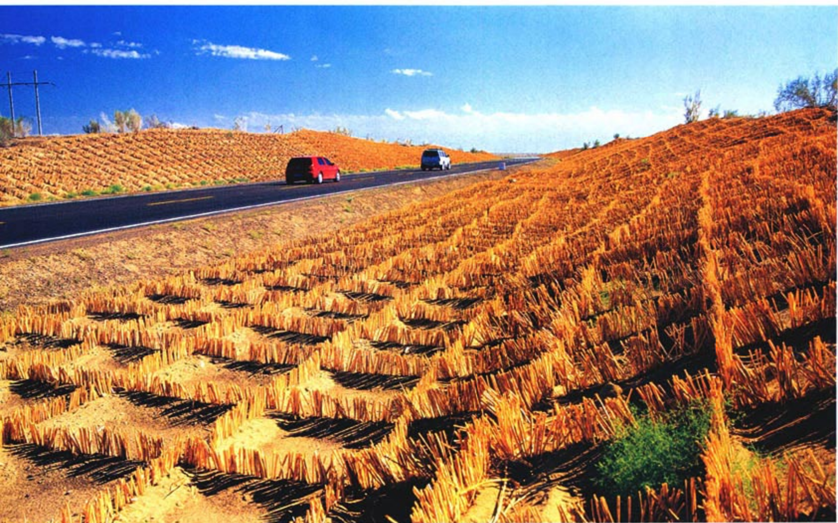
沙坡头治沙的成功，使麦草方格成为了世界著名的固沙方法，在后来它还被广泛应用于其他的地区，并且演化出了种种不同的面貌。在塔里木沙漠公路两侧，用芦苇扎成的草方格正忠实履行着自己固沙护路的职责。摄影 / 郝沛
