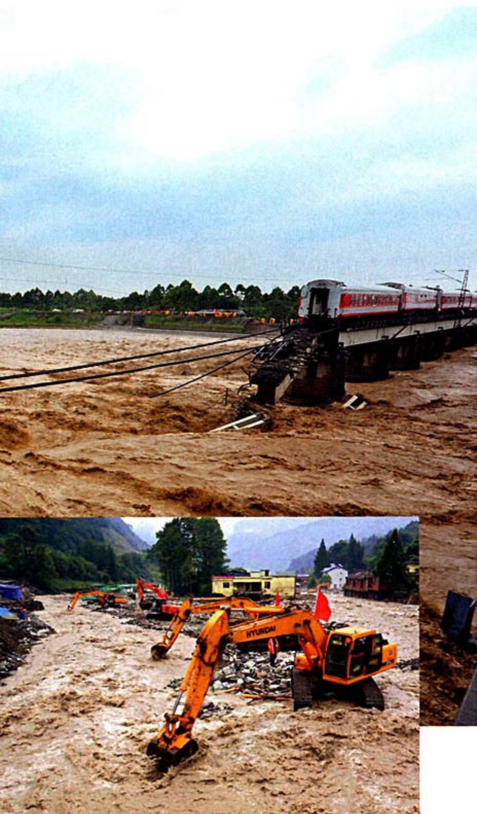
龙池泥石流灾区现场,挖土机正在排除河道中的石沙。摄影/王红强
