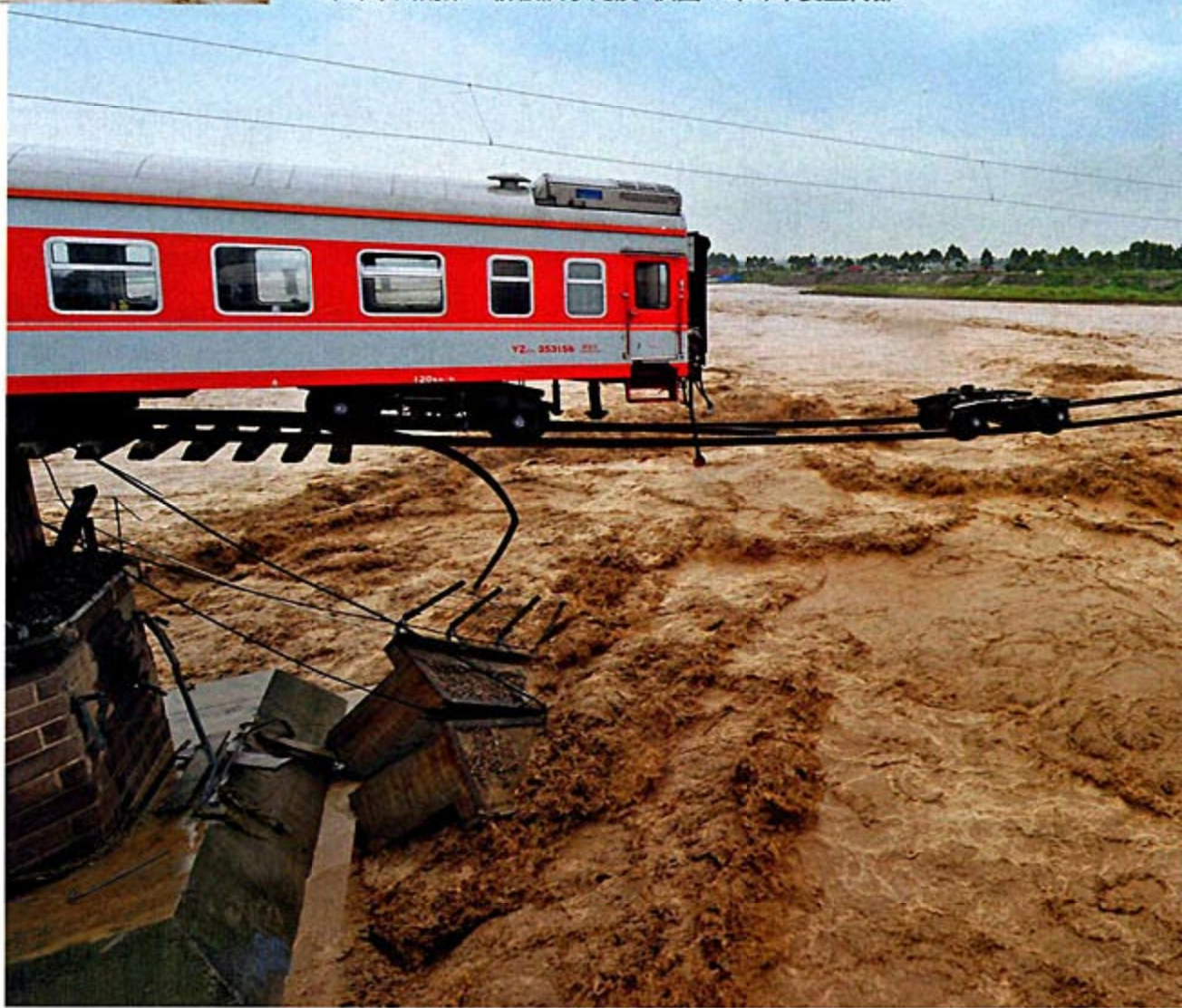
广汉市石亭江铁路大桥被洪水冲垮, 行驶在桥上的火车掉下两节车厢。摄影 / 程果
