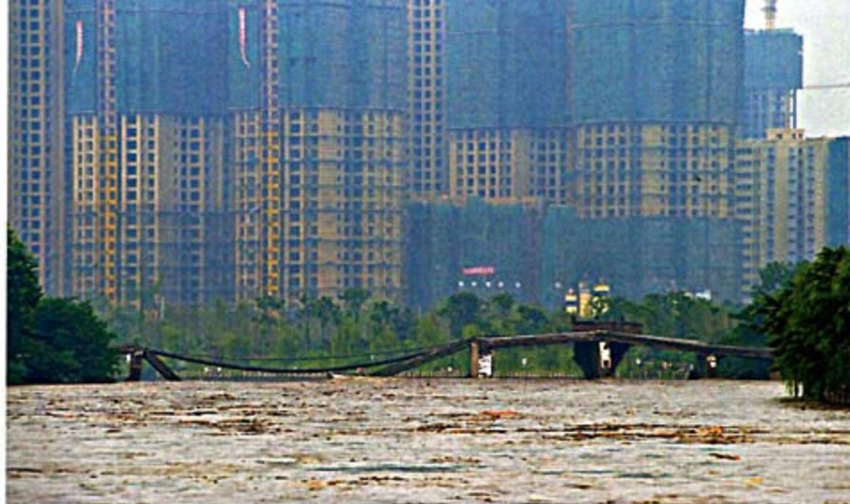
双流县华阳镇通济古桥被冲垮 摄影 / 员林
