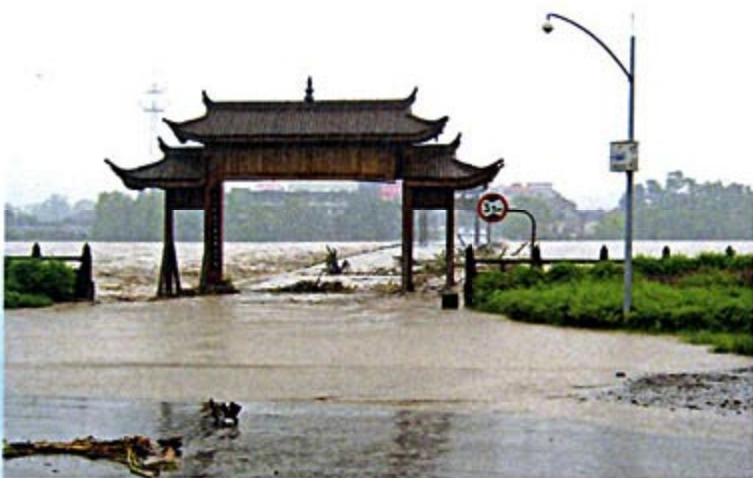
邛崃市川南第一桥被洪水淹没 供图 / 邛崃市委宣传部
