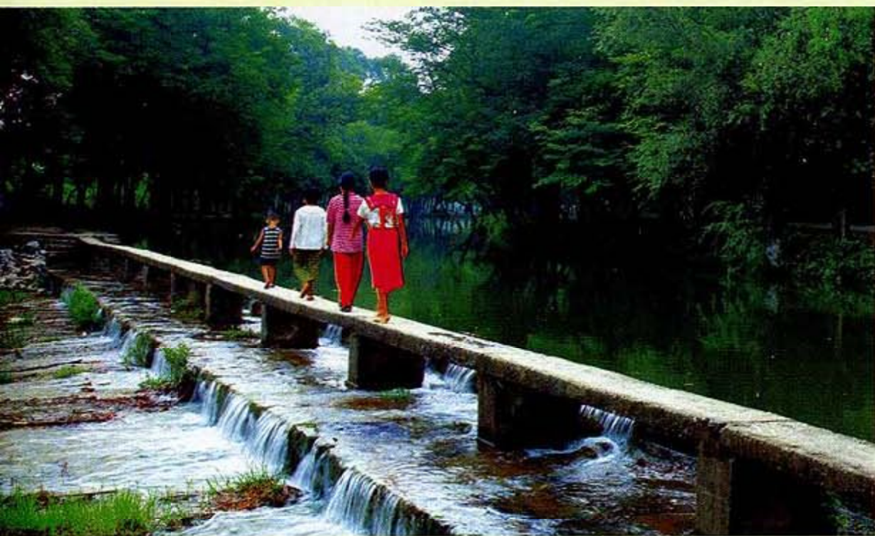
灵渠上建有多处溢流堰，如泄水天平、马嘶桥溢流堰、竹枝堰、回龙堤等。它们的坝顶高度略低于渠岸，平时可以当作堤防，汛期则可全坝顶溢流泄洪，从而保证渠岸安全。图为南陡以下约1公里处的泄水天平，在正常年份的洪水量都能由此排入湘江故道。其坝顶还建有石墩、石桥，是从兴安县城去大小天平的主要通道。摄影/张小宁
