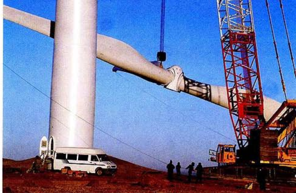
上:张北国投风力发电厂的技术人员正在组装风力发电机。
