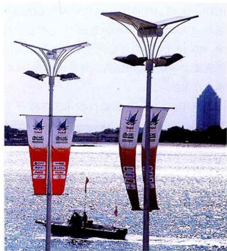
青岛国际帆船赛赛场内的太阳能景观灯。2006年的夏天，40多盏风能灯和100多盏太阳能景观灯亮相青岛国际帆船赛赛场。但愿在不久的将来，可再生能源环保灯不再仅仅是某个重要场景的点缀，而是更多地取代普通路灯。 新华社 摄影/钮一新
