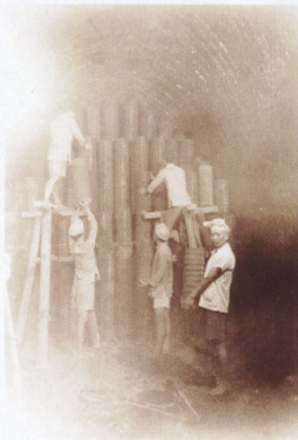
上世纪50年代景德镇窑工“满窑”的工作照。“满窑”是老式柴窑最重要的生产流程之一，随着柴窑被废弃、瓦斯窑兴起，现在已不复见。
