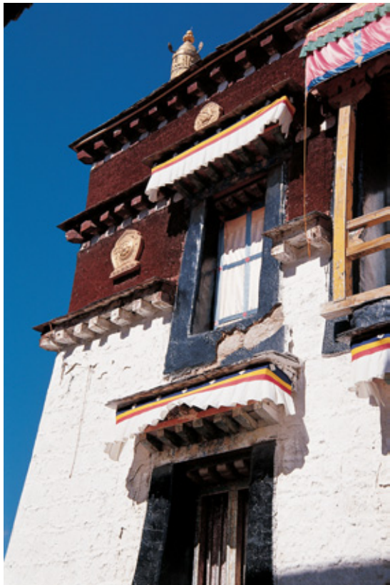
大昭寺中心佛殿的第一、二层受印度僧房建筑的影响，平面布局略成方形，门朝西向，外侧砌砖、石承重墙，内侧为木构架，二者组合成内院式建筑。
