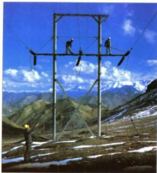
祁连山上的高压电缆
