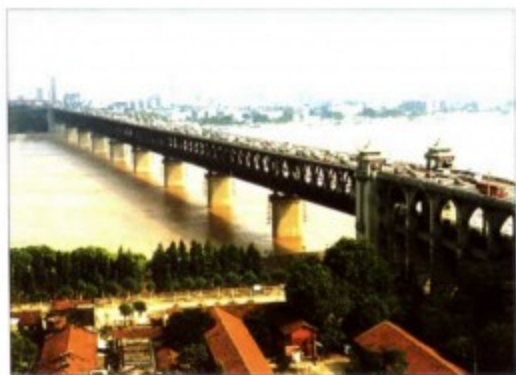
武汉长江大桥
