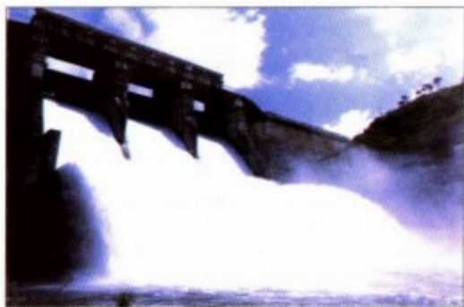
晋江上游的西溪水电站
