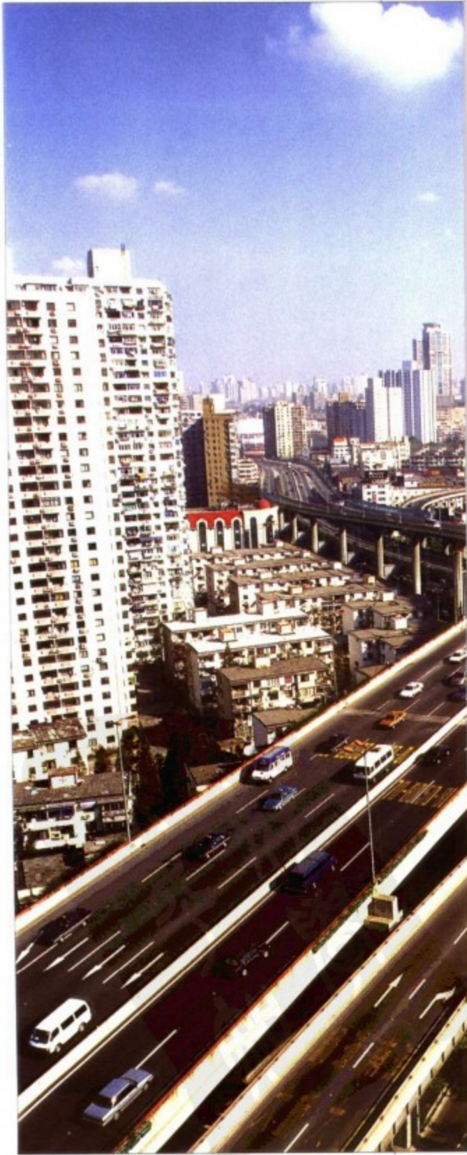
上海延安西路高架桥
