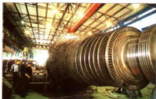
北京华能热电厂是一座高标准环境保护型热电联产的燃煤电厂。图为巨大的发电机转子正吊装就位。
